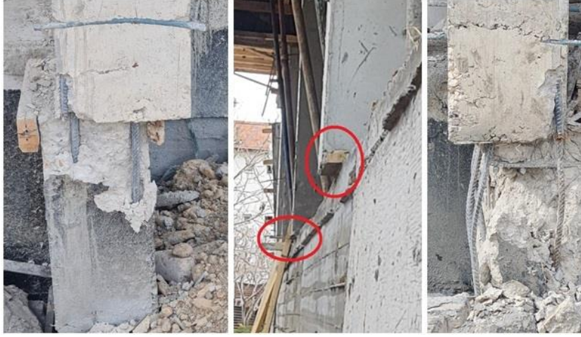
Görsel 6. Aks ve kalıp hataları
