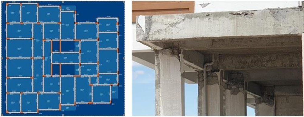
Görsel 1. Yetersiz perde duvar
