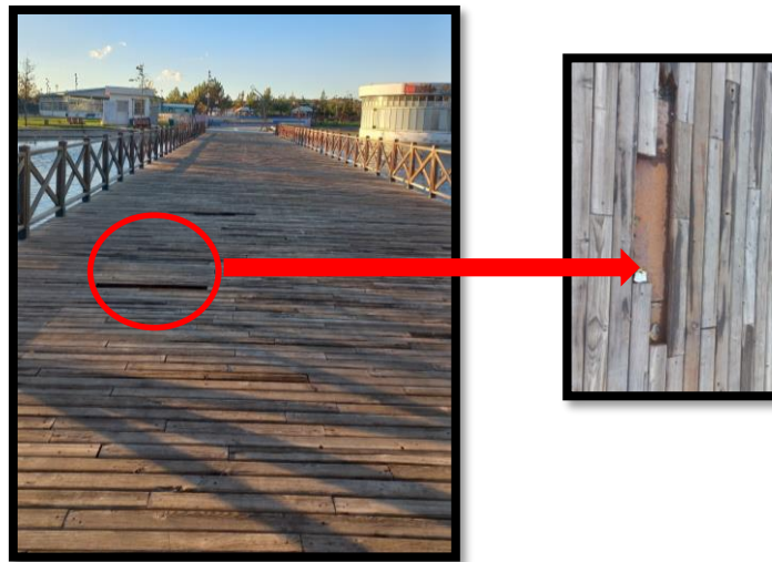
Görsel 28. Ahşap köprü engelsiz olmayan yüzeylerin kullanımı
