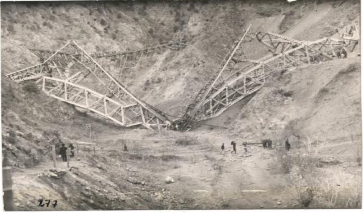
Görsel 7. Başköy Köprüsü'nde Yaşanan Patlamamın Görseli [18]
