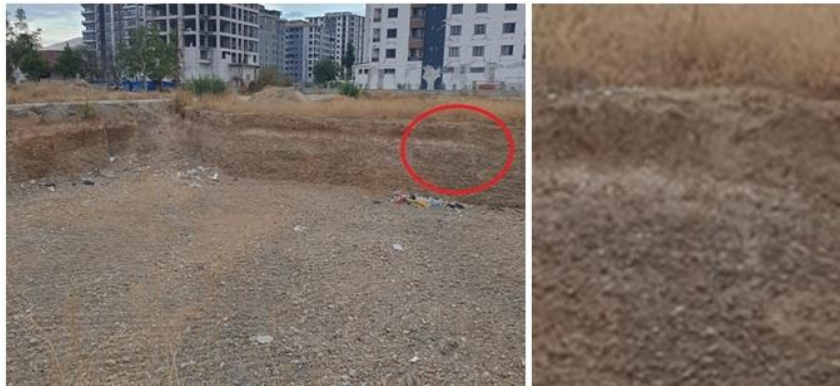
Görsel 7. Zemin problemleri
