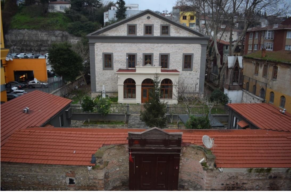
Görsel 1. Batı Giriş Cephesi Görünüşü, Serdar Kasap, 2018
