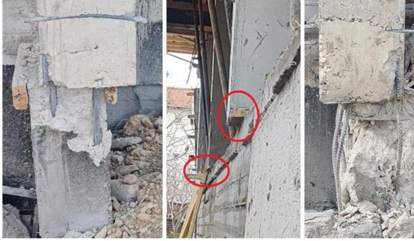
Görsel 6. Aks ve kalıp hataları
