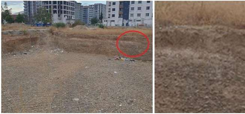
Görsel 7. Zemin problemleri
