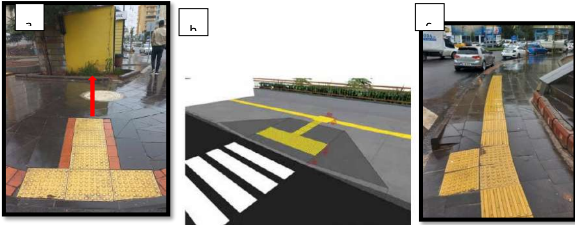
Görsel 5. Otogar Caddesi Yaya Geçidinde Üç Yöne Eğimli Rampa (Ft: a; Medine ÇELİK, b:Erişilebilirlik Kılavuzu, (2020), c; Medine ÇELİK)
