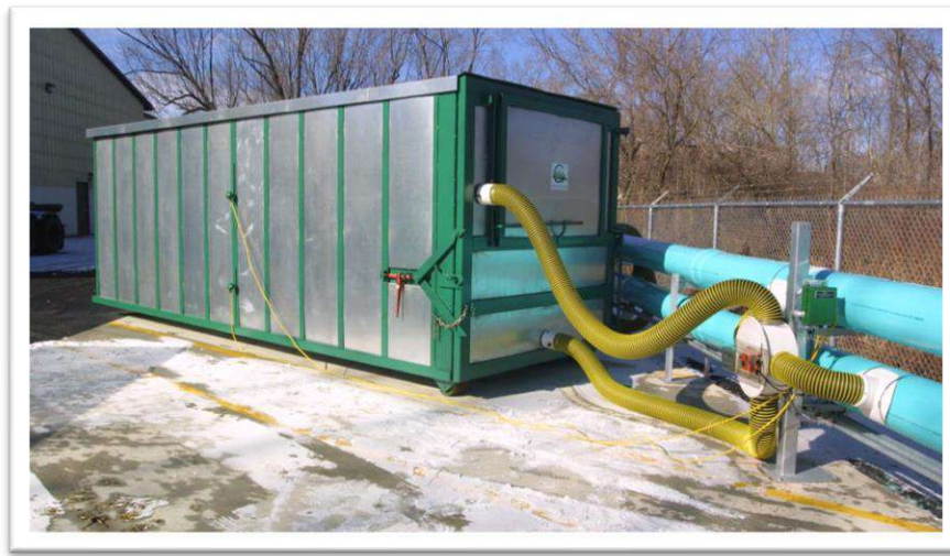
Şekil 10. Zorlanmış havalandırmalı kapalı konteyner içi kompost sistemi (Anonim 2024e)
