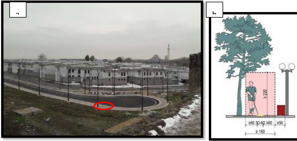
Görsel 8. Sur Caddesi Açık Alanda Kılavuz Yüzey Uygulaması (Ft: a; Medine ÇELİK, b:Erişilebilirlik Kılavuzu, (2020))
