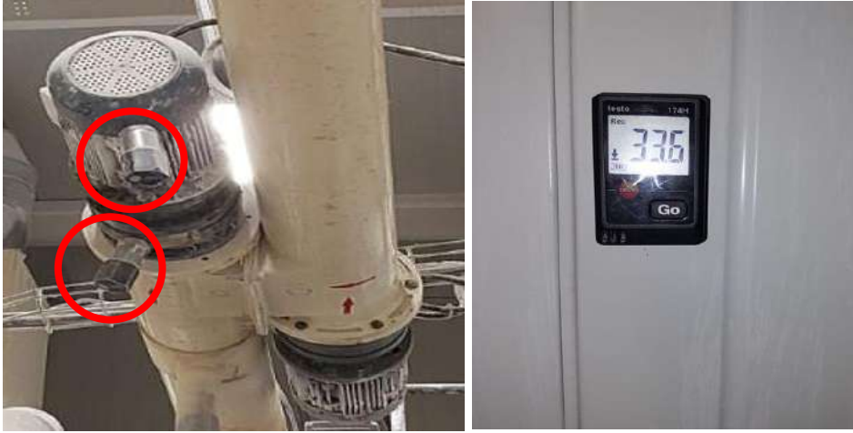
Görsel 2. Sıcaklık/titreşim ölçer sensörlerin ve datalogger görünümü
