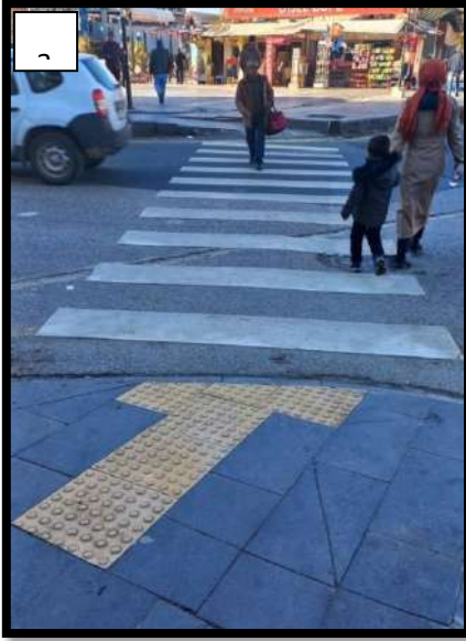
Görsel 14. Dağkapı Meydanı Tek Yöne Eğimli Rampa (Ft: a; Medine ÇELİK, b:Erişilebilirlik Kılavuzu, (2020))
