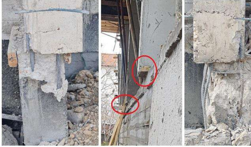
Görsel 6. Aks ve kalıp hataları
