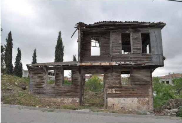
Görsel 3. Yapının uygulama öncesi özgün durumu (B. Kartal Mimarlık)
