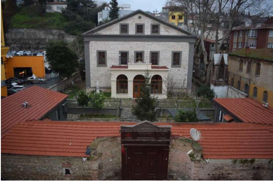
Görsel 1. Batı Giriş Cephesi Görünüşü, Serdar Kasap, 2018
