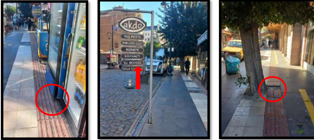
Görsel 13. Gazi Caddesi Kaldırımında kullanılan hissedilebilir yüzeylerin kullanımı
