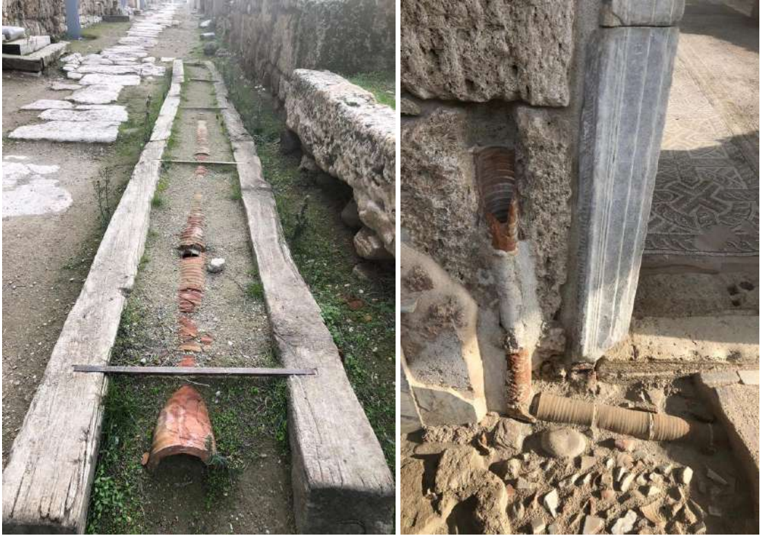
Şekil 6. Loadikeia Antik kent içerisinde sulama ağı yapısı-sulama boruları.
