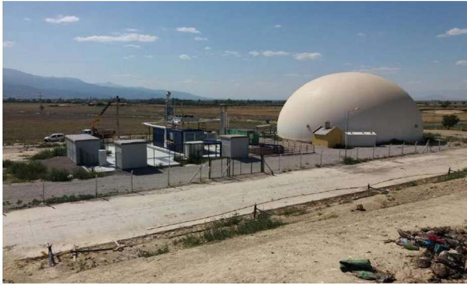
Görsel 11: Akşehir Enerji Üretim Tesisi
