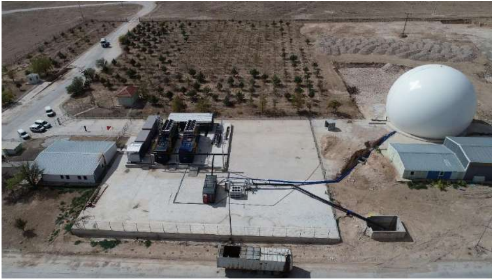
Görsel 13: Cihanbeyli Enerji Üretim Tesisi
