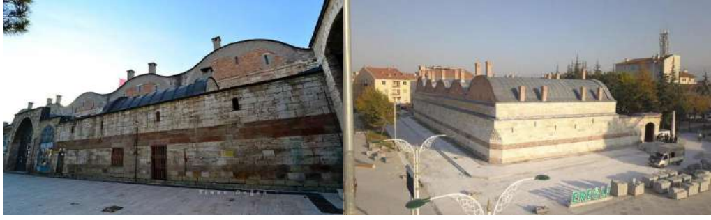
Görsel 11: Rüstem Paşa Kervansarayı (Restorasyon Öncesi ve Sonrası)
